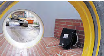
Der mit Klinker ausgekleidete Kontrollschacht in der Elbstraße: Hier fließt nun das Abwasser durch.
