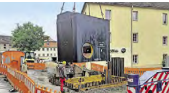
6 Tonnen hängen hier am Haken: Am 30. Mai 2024 wurde der neue Kontrollschacht in die Elbstraße eingesetzt.
