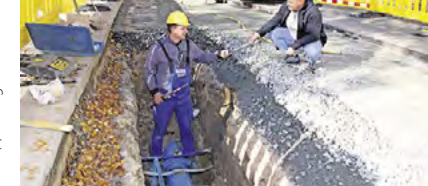
Altes raus, neues rein: In der Domnitzscher Straße werden Trinkwasserleitungen neu verlegt.
